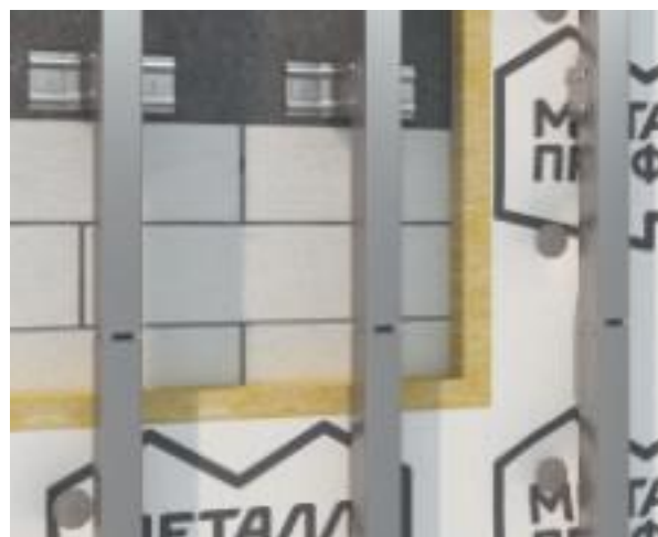
Крепежные кронштейны межэтажные ККМ-90 (120, 150, 180 и 230), t=1,2 мм и 2,0 мм
