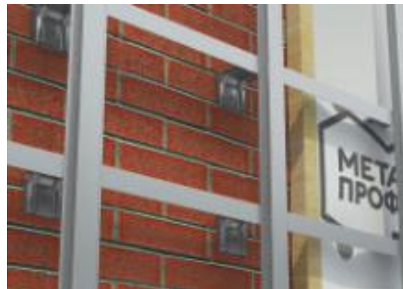
Система с перекрестным расположением основных профилей
