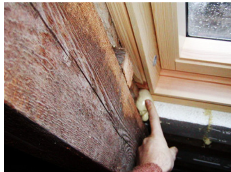
Не используйте монтажную пену для установки мансардного окна.
